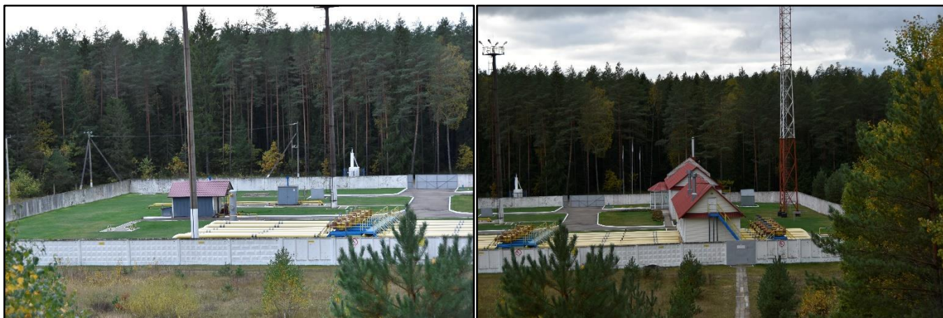
Рисунок 2.1 – Газоизмерительная станция «Котловка»
