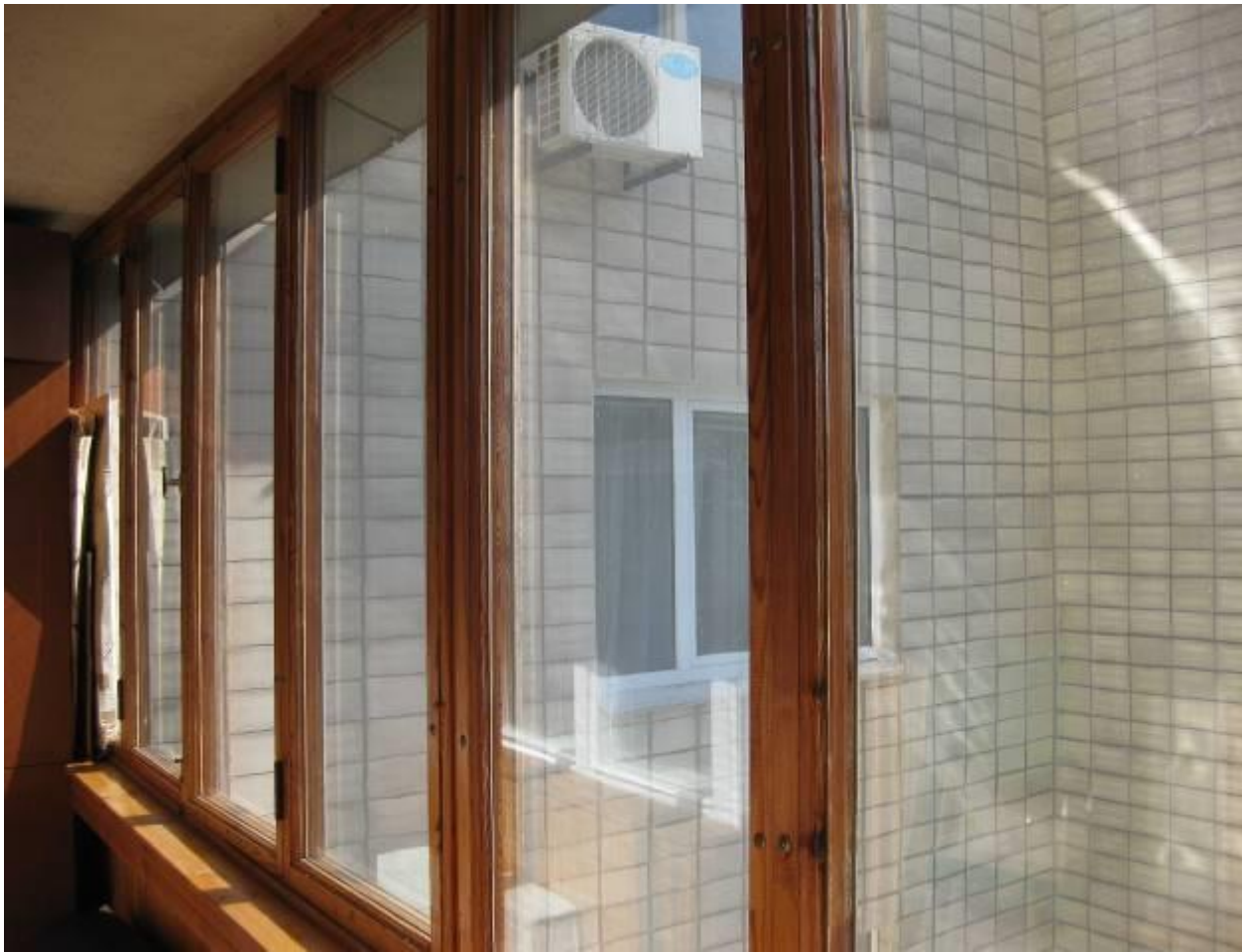
Холодное остекление балкона деревянными рамами
