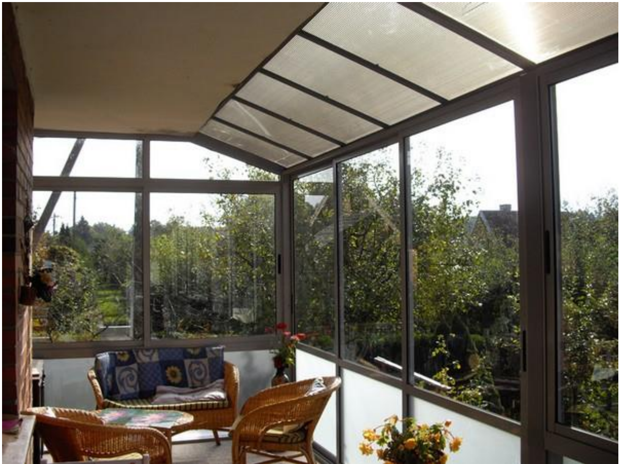
Остекление балконов ПВХ
