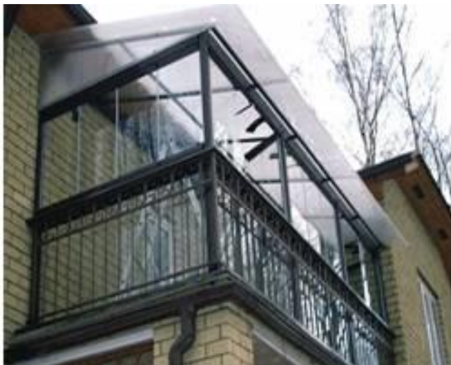
Крыша балкона сделана из листов поликарбоната
