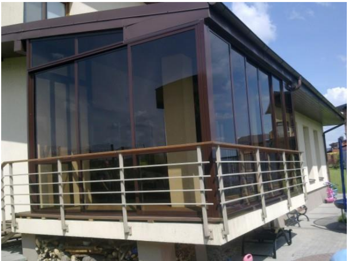
Остекление балконов ПВХ
