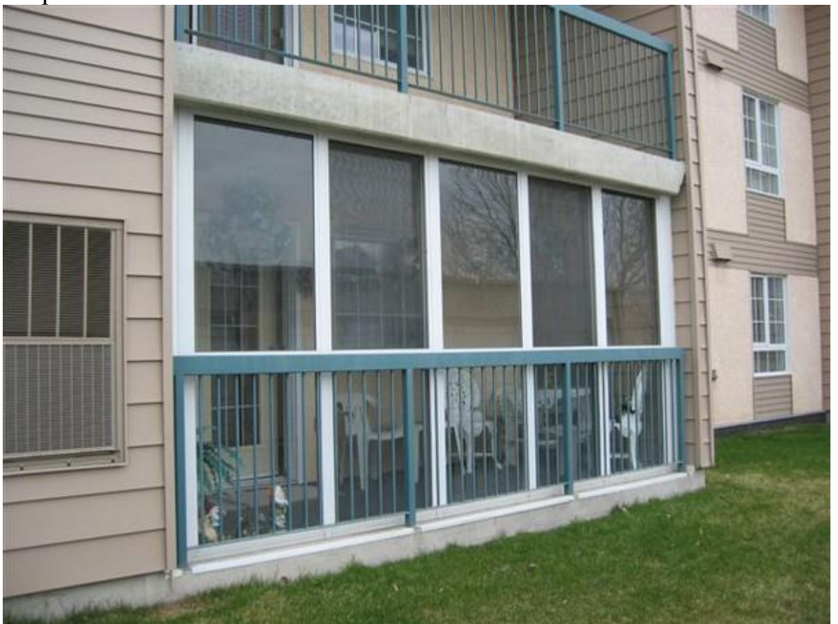
Остекление балкона ПВХ
