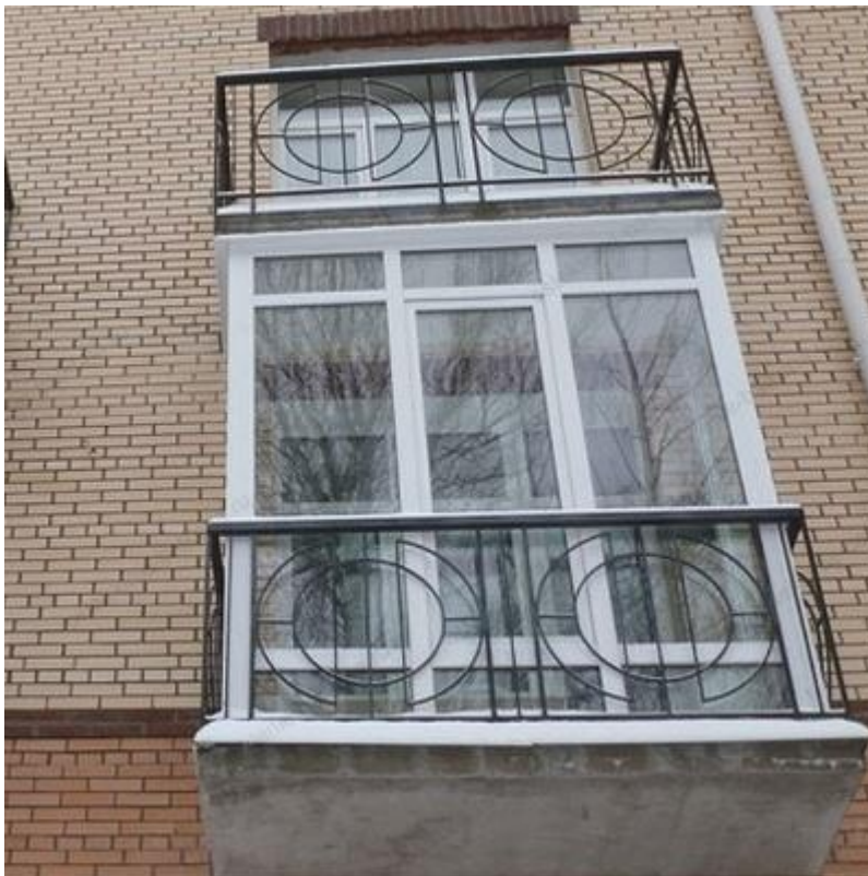
Рамы остекления устанавливаются на плиту балкона или лоджии
