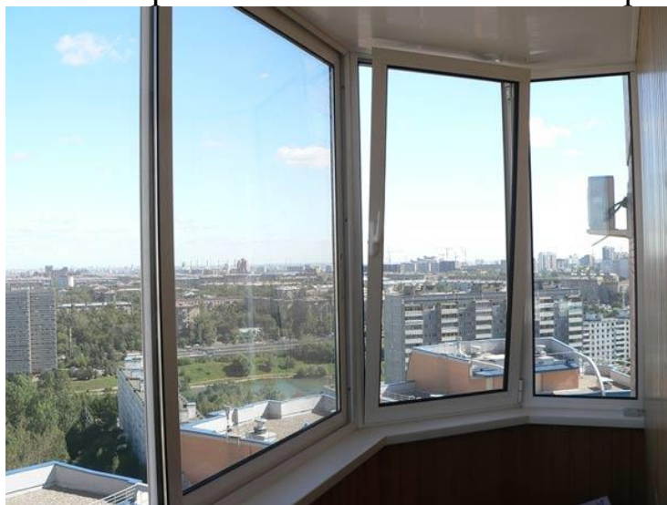
Распашные конструкции из ПВХ профиля
